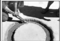
5. Wytłaczać materiał w sposób ciągły w miejsce, które ma być uszczelnione.
