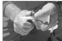
2. Przeciąć dyszę poprzecznie na takiej wysokości, która odpowiada wymaganej średnicy otworu dyszy.
