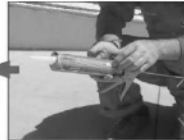
4. Włożyć nabój do pistoletu wyciskowego.
